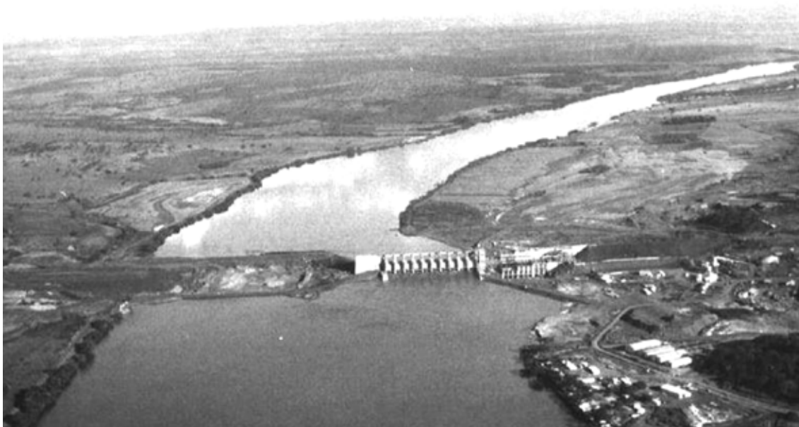
Figura 1: Foto da barragem de Volta Grande na época de sua construção. Fonte: Cemig
