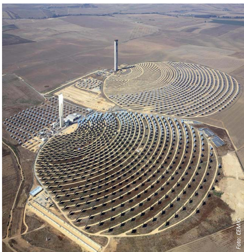
Figura 2.3.11: Usinas Solares do Tipo Torre de Potência: Solar II e PS10 / Fonte: CEMIG
