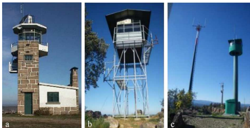
Figura 45 - Sistema tradicional de detecção terrestre fixa: a) Construção de alvenaria; b) Torre metálica; c) Torre metálica de uma só componente.
