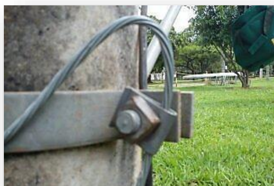
Foto 3 – Detalhe de montagem do cabo de aço 6,4 mm para o aterramento de ferragens.
