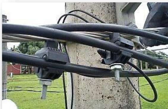
Foto 2 – Detalhe da ligação dos cabos de 1,5 mm 2 através dos conectores de perfuração.
