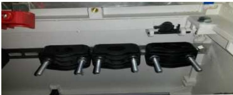
**Foto 2 – Conectores com Proteção**
