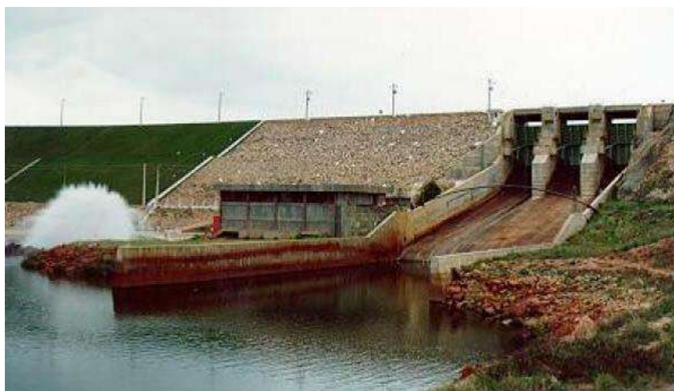
Figura 1 – Vista da barragem
