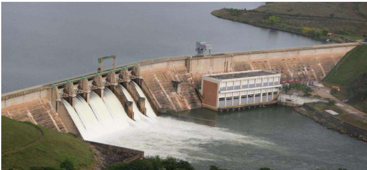
Figura 1 – Barragem da UHE Camargos
