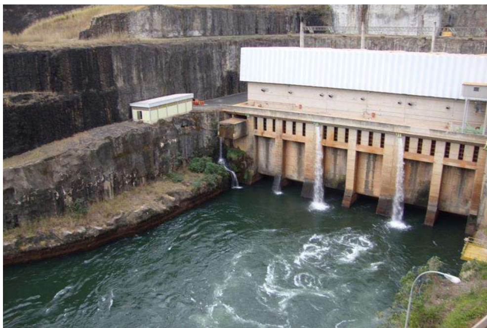
Figura 2 – Casa de força
