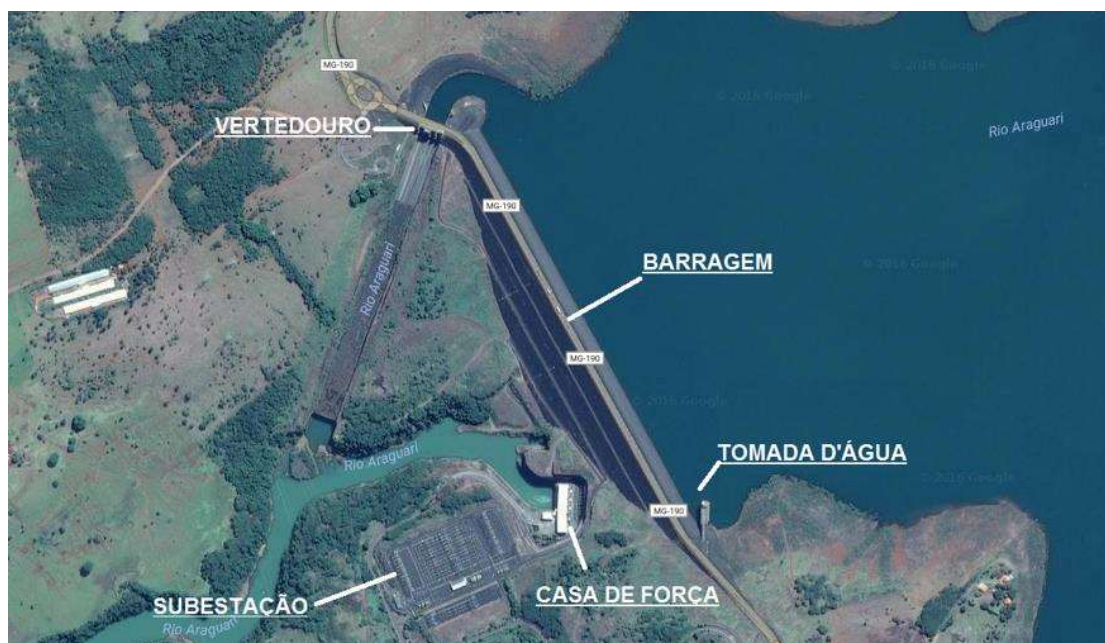
Figura 1 - Vista superior da barragem
