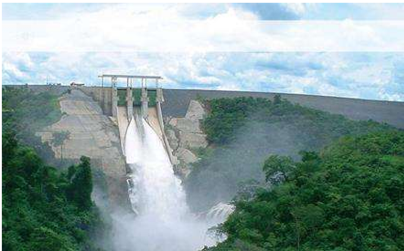
Figura 1 - Vista da barragem e vertedouro
