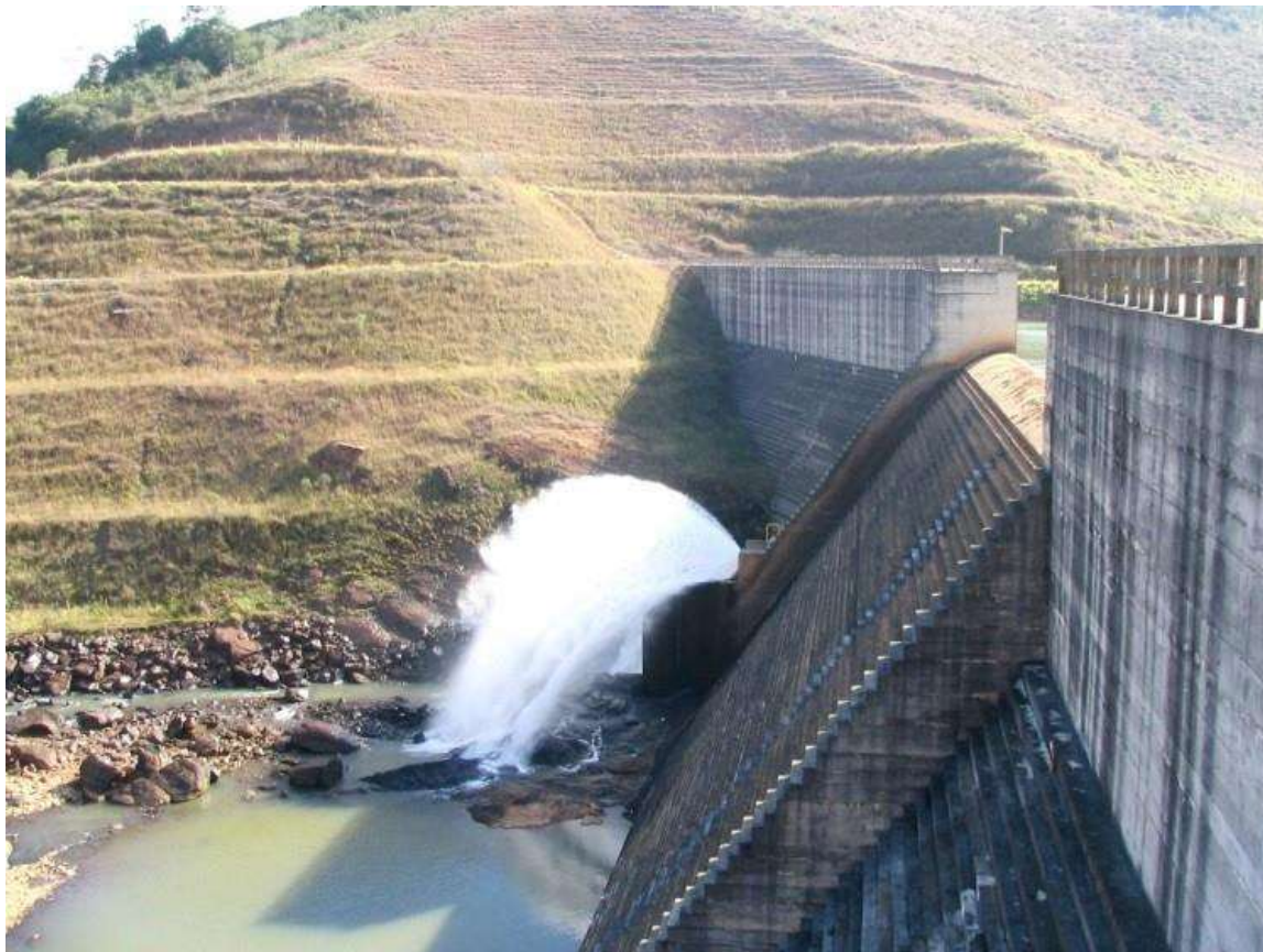
Figura 1 - Vista lateral a jusante da barragem
