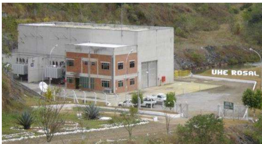
Figura 2 - Casa de força
