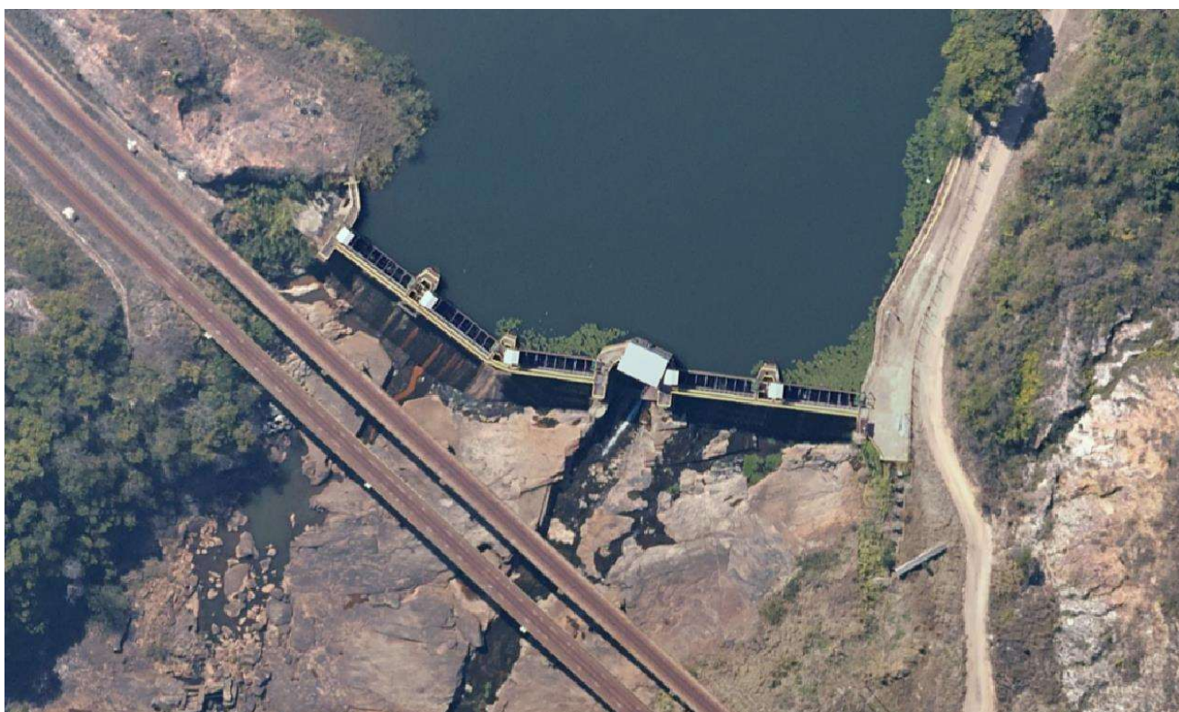
Figura 1 - Vista superior da barragem Antônio Dias
