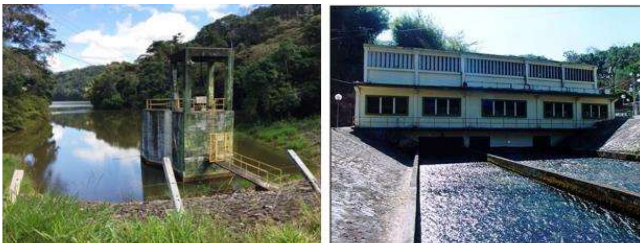
Figura 1 – Tomada d'água (esquerda), casa de força e canal de fuga da UHE Tronqueiras (direita)
