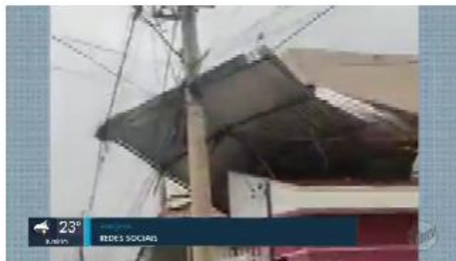
Forte chuva com ventos e granizo faz cobertura de prédio voar sobre fiação de casas
