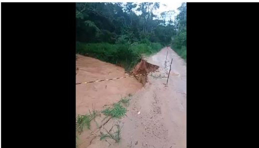
Parte da estrada de Cachoeira Jurumirim foi levada pela chuva
