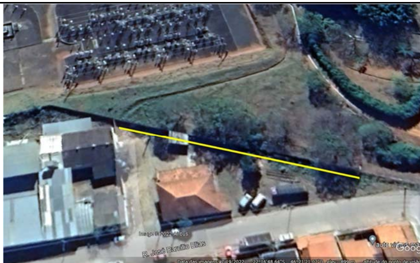
Figura 03 – Local a ser construído canaleta
