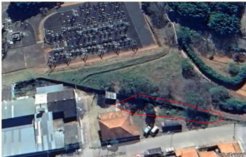
Figura 02 – Trecho do muro para ser removido terra/entulho
