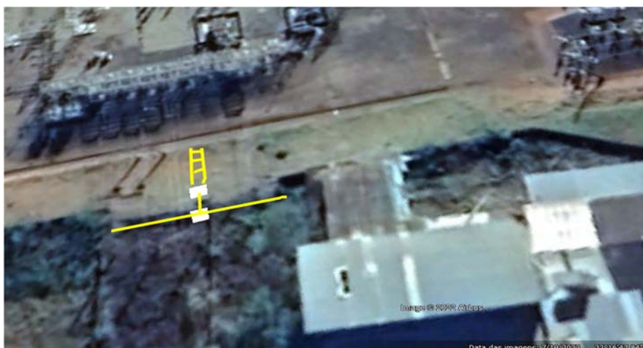
Figura 06 – Local do muro a ser construído valas e caixas coletoras de água.
