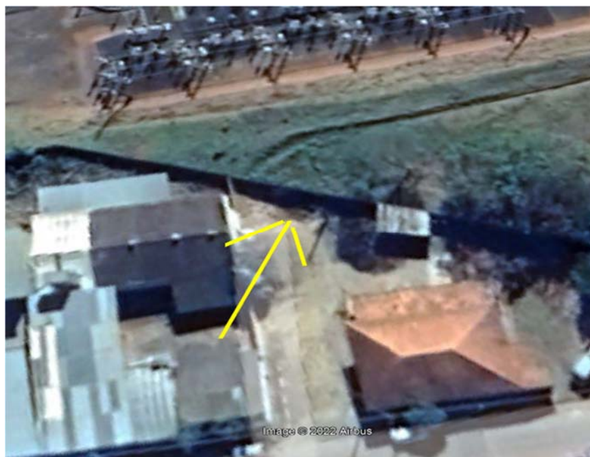
Figura 04 – Local a ser construído caixa coletora.
