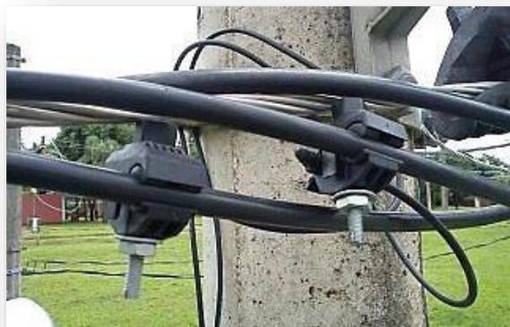
Foto 2 – Detalhe da ligação dos cabos de 1,5 mm<sup>2</sup> através dos conectores de perfuração.
