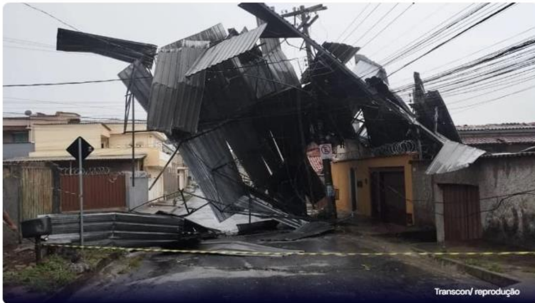
Bombeiros foram acionados na rua Rio Paraopeba, 768, no bairro Riacho das Pedras
