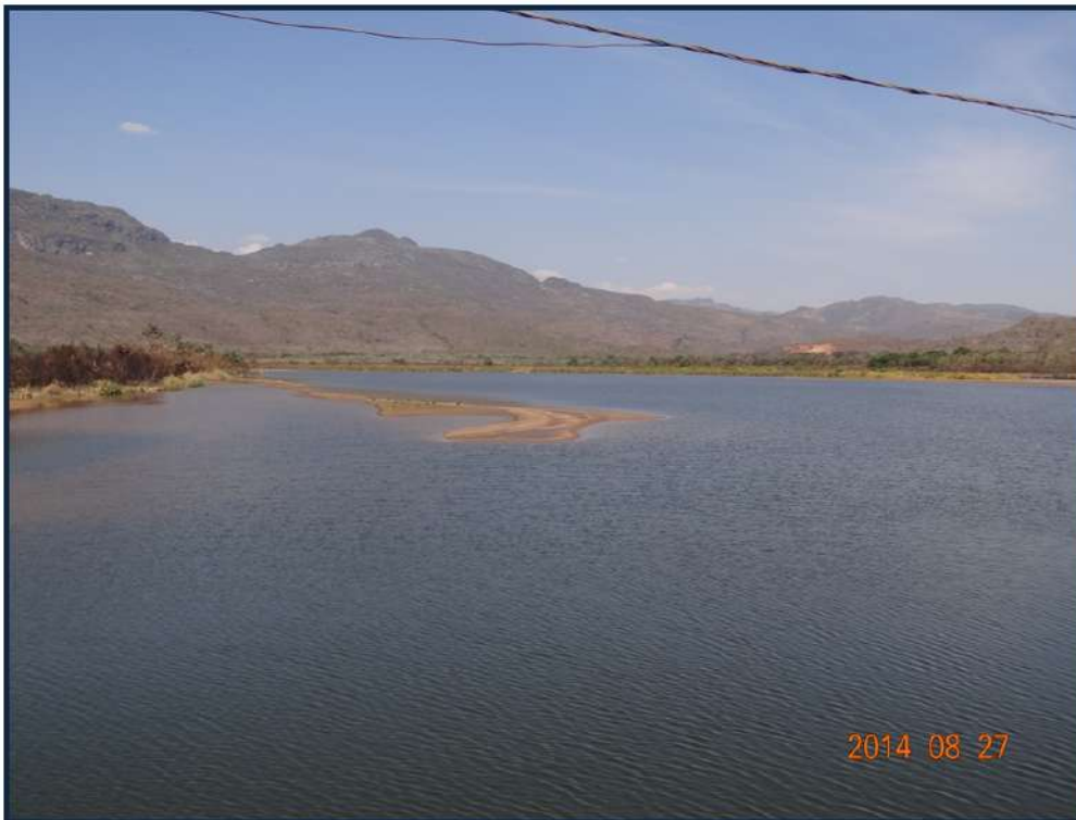
Foto 3 - Assoreamento do reservatório na parte central. O processo encontra-se em estágio avançado em função do elevado carregamento de sedimentos oriundo de montante da bacia do rio Paraúna.
