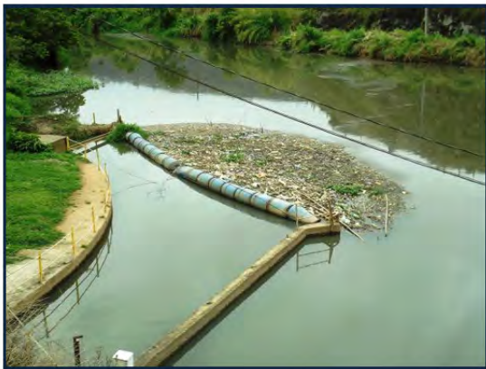
Foto 27 - Sistema de barramento do lixo que localiza-se a montante da barragem.
