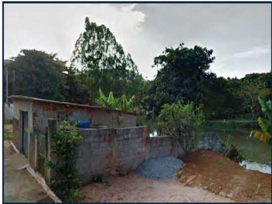
Foto 5 - Construção irregular e aterramentos nas margens do reservatório no Bairro Bethel.
