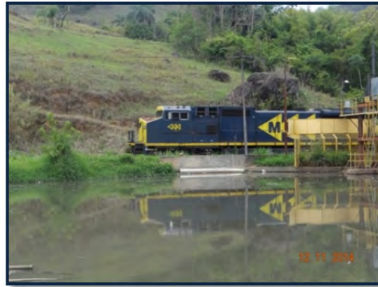
Foto 40 - Vista da linha férrea a poucos metros do reservatório da PCH Joasal.
