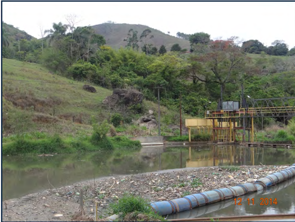
Foto 33- Relevo suave ondulado a ondulado à montante do barramento da PCH Joasal
