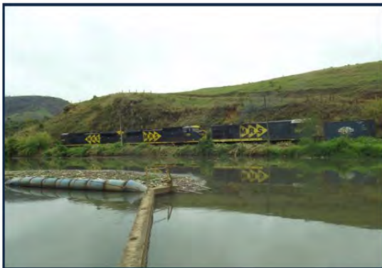
Foto 19 - Ferrovia que passa as margens do reservatório. Estrutura de interesse social típica do início do século XX no Brasil.
