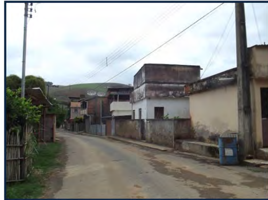
Foto 4 - Via que margeia o reservatório e característica construtiva do bairro com população de baixa renda. Sistema de drenagem inexistente ou precário.
