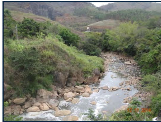
Foto 42 - Vista do trecho de vazão reduzida entre o barramento e a casa de força. Ausência de mata ciliar em uma das margens.
