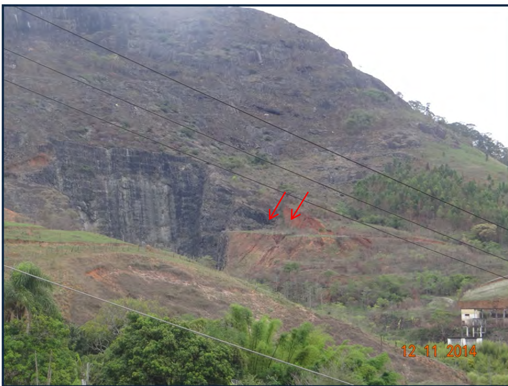
Foto 36- Ravinamentos e sulcos erosivos na área de entorno da PCH Joasal. (Coordenadas UTM/WGS84: 515505E/ 777587N)
