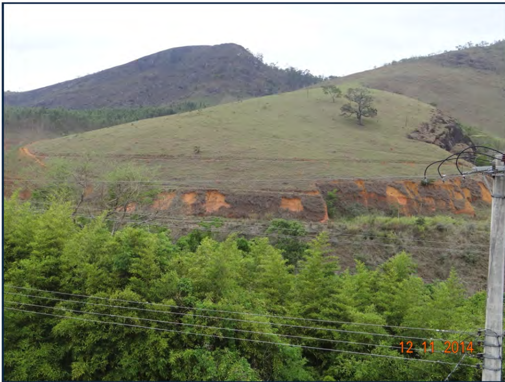
Foto 37 - Vista dos taludes da linha férrea na Área de Entorno da PCH Joasal. (Coordenadas UTM/WGS84: 675923E/ 7588281N)
