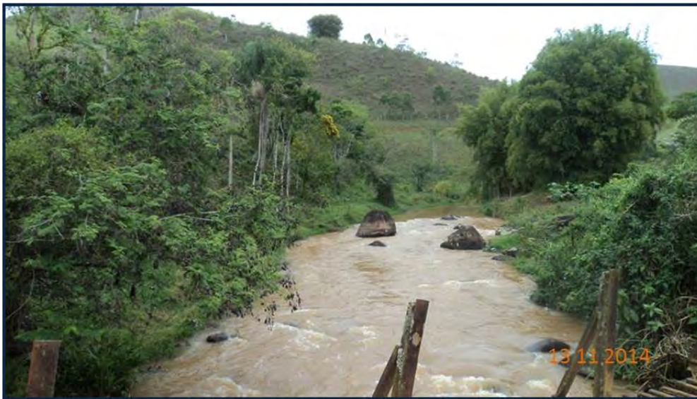
Foto 07- Rio do Pinho apresentando padrão meandrante a montante da barragem da PCH Piau.
